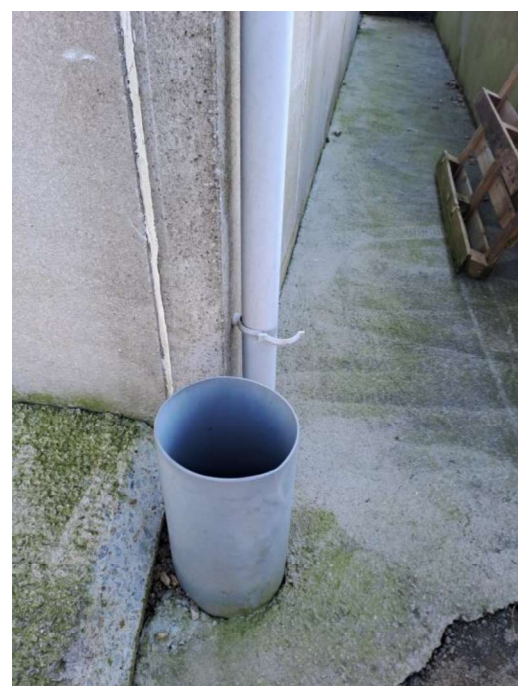
Photographie 5 : Protection du réseau pluviales P10
