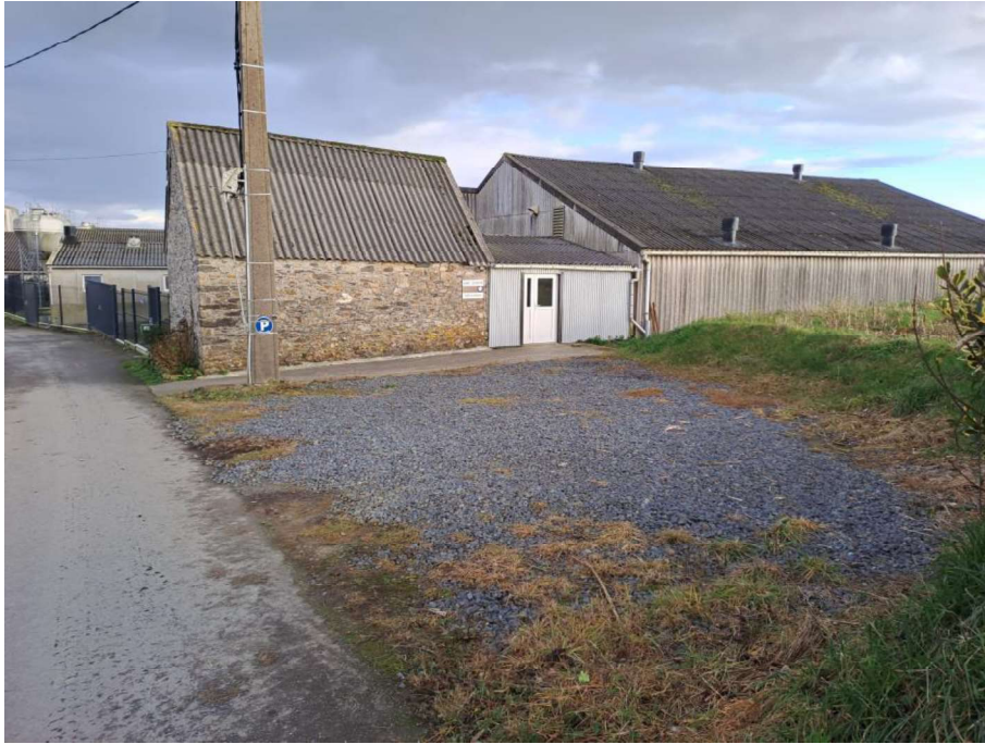
Photographie 1 : Entrée de l'élevage de la SCEA LE ROUX-Pors Ar Glouet-côté droit du chemin d'accès
